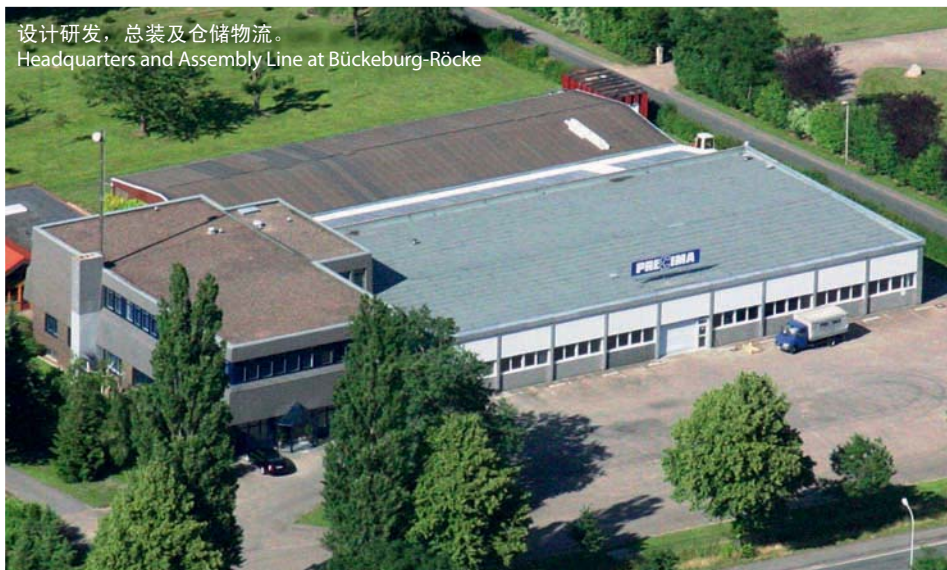
CNC加工生产中心 Plant II - CNC Production at Bückeburg-Müdingen
