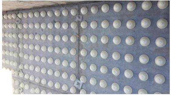
长柄滤头应用于滤池汽水反冲洗配水系统;短柄滤头应用于滤池 单水反冲洗和重力式、压力式滤罐及离子交换滤床等配水过滤系统。 滤头既可适用于生活饮用水处理,也可适用于饮料、印染、游泳池等 各种工业用水处,同样可以应用于工业废水,生活污水的处理工程中。 滤头滤帽按流量分为 0.25 吨/小时,0.5 吨/小时,1 吨/小时三种。
