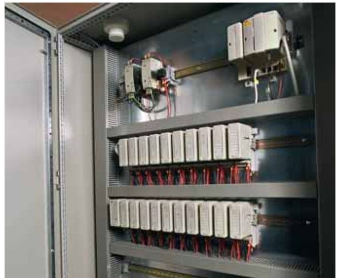
AC800M 控制器与 I/O 实景图
